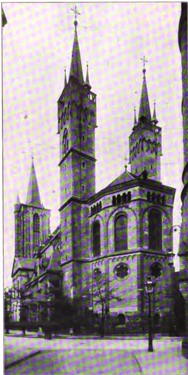
Abside de l'église Saint-Séverin.
